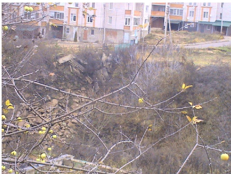
*Рис. 4-11. Оползневой участок Верхнее-Рачевский. Оползень на борту отвержка оврага засыпанный строительным мусором*
