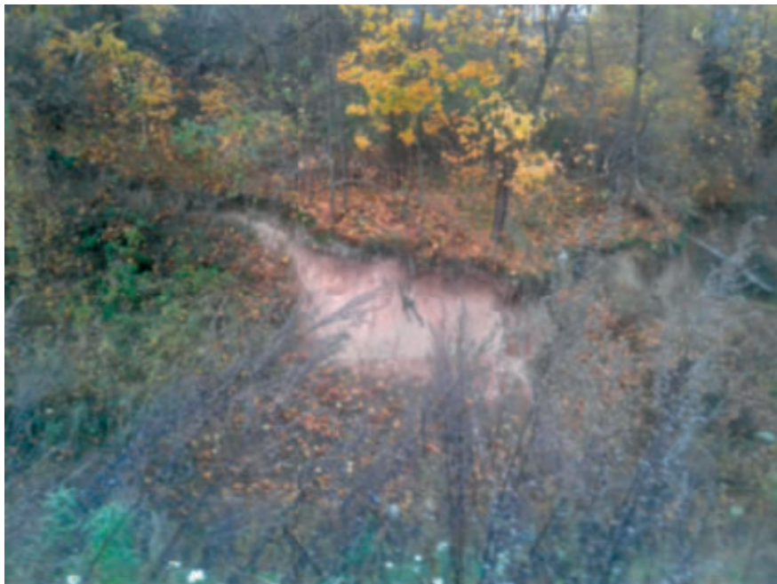
Рис. 7-11. Оползневой склон (участок Верхне-Чуриловский)
