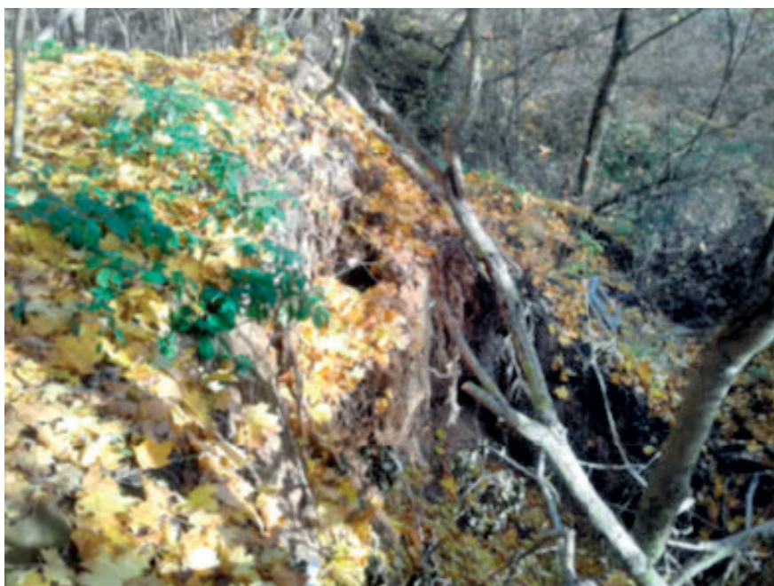
Рис. 7-4. Оползневой склон промоины (участок овраг Чертов ров)
