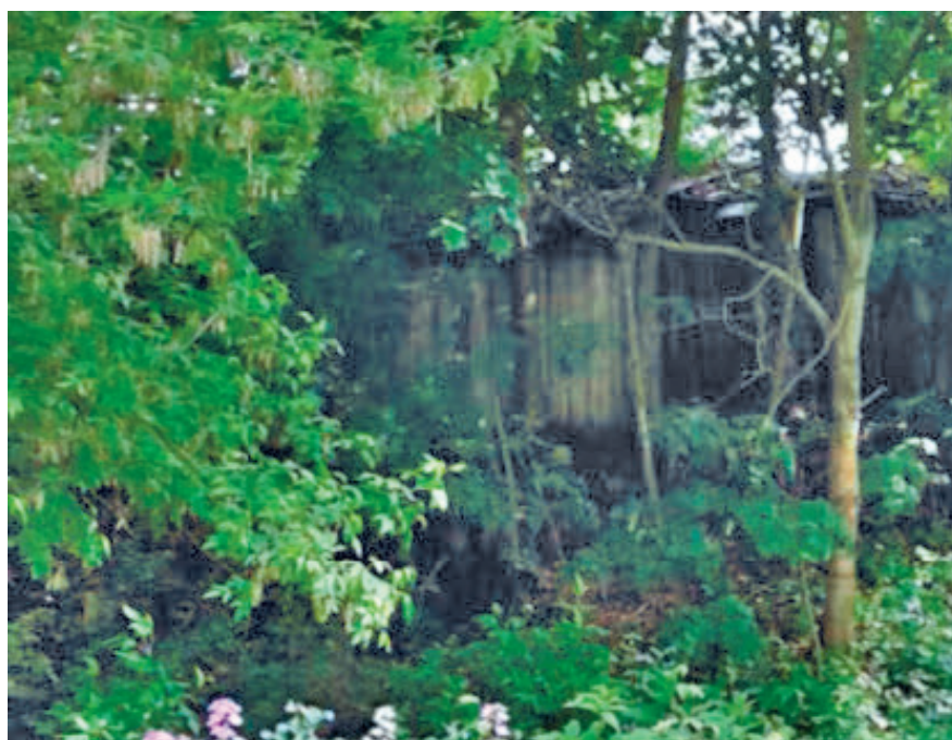
Рис. 7-8. Оползневой склон (участок Рачевский-Западный)
