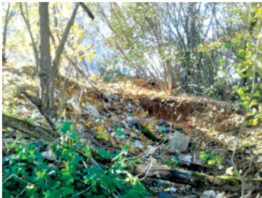
Рис. 7-1. Оползневой склон промоины (участок Кловский овраг)
