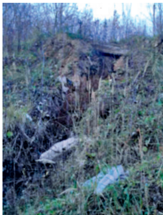
Рис. 7-6. Промоины на оползневом склоне (участок Верхне-Рачевский)
