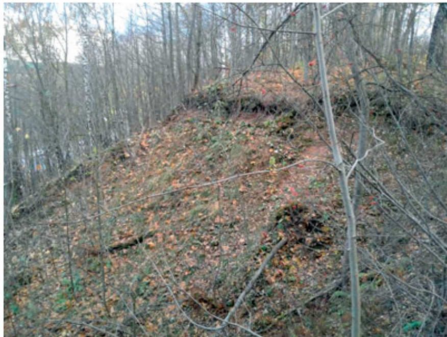
Рис. 7-9. Оползневой склон, тело оползня (участок Рачевский-Восточный)
